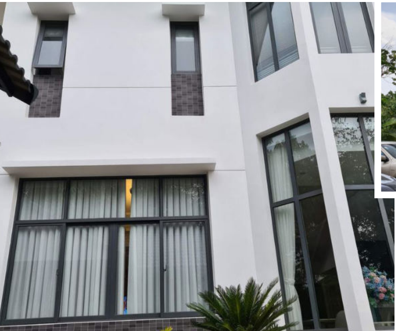
9. BIỆT THỰ LONG THÀNH LONG THANH PRIVATE HOUSE
